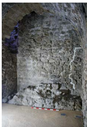
Torre 6, interior. Aspecto general tras la intervención de 2022-2023 antes de colocar la escalera metálica de acceso al terrado. Se observan los restos de la escalera original medieval.
