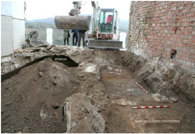
C/ Adarve, 15. Localización de la cota arqueológica para su protección y no afectación por las obras.
