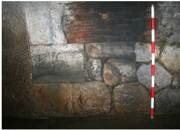
Detalle del estribo de un puente contemporáneo soterrado en la canalización-colector c/ Arenal y c/ Barranco.
