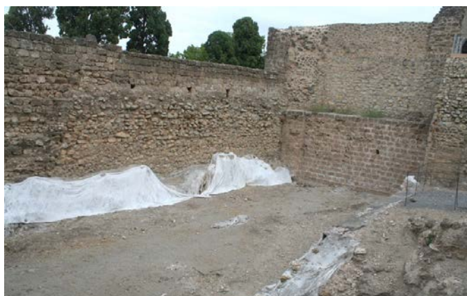
Vista parcial del Sector NW del castillo de Priego, una de las propuestas de intervención previstas pendientes de financiación.
