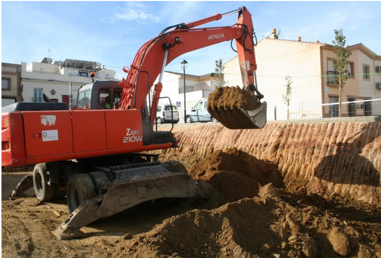
Movimiento de tierras asociado a la edificación de la parcela de c/ Ramón y Cajal, 101 (edificio Mercadona).
