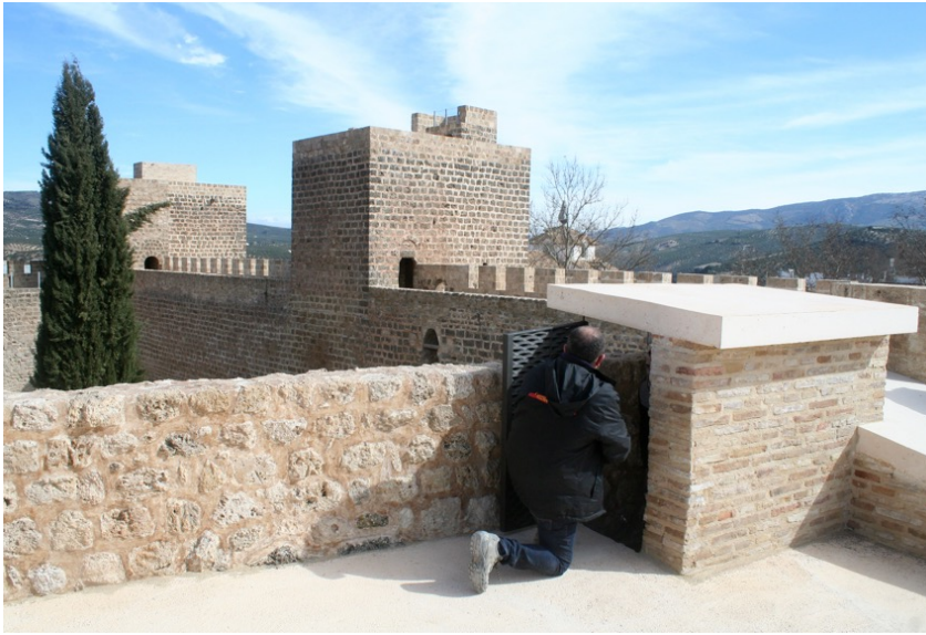
Ultimando detalles en el acceso al terrado de la Torre 6 del castillo. Al fondo, las Torres 2 y 3.
